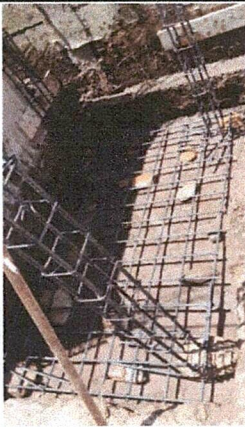
Foto 3: MEJORAMIENTO DE PILA
