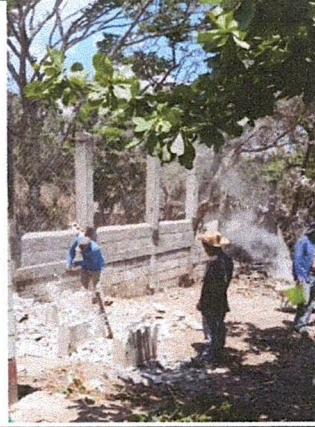
Foto 4: MEJORAMIENTO DE SANITARIO
